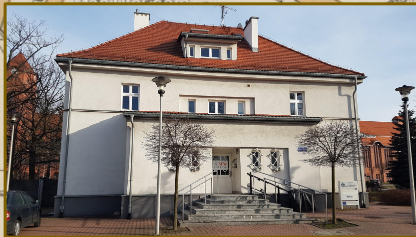
Znajdująca się przy ul. Kopalnianej willa zarządu
